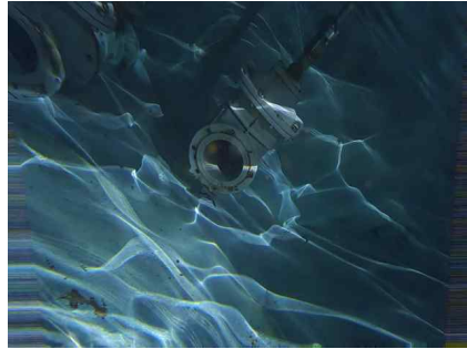
<2지 유출배관 상태양호>
