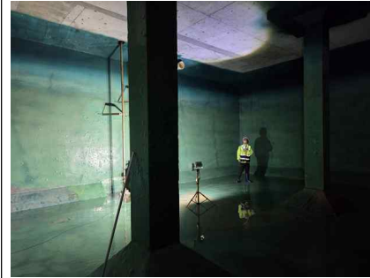
<내부 개별부재 외관조사>
