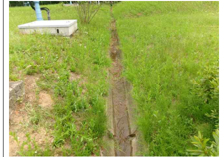
<부대시설 배수로 전경>
