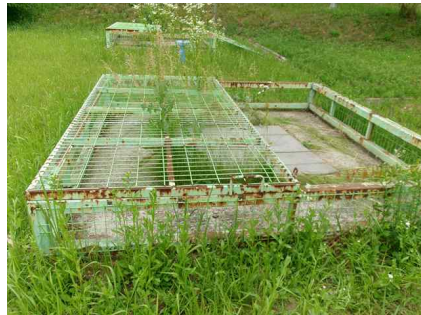
<내부 안전펜스 상태양호>
