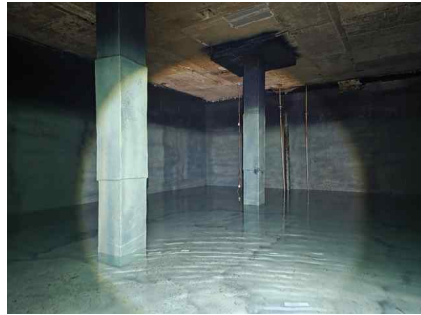
<배수지 2지 전경>
