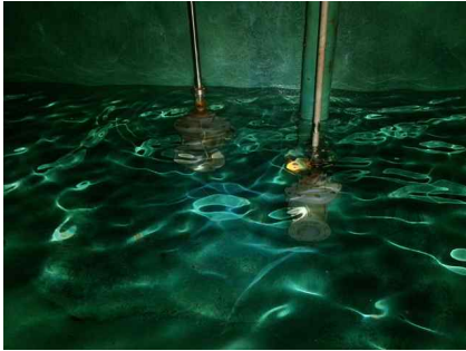
<1지 유출배관 상태양호>
