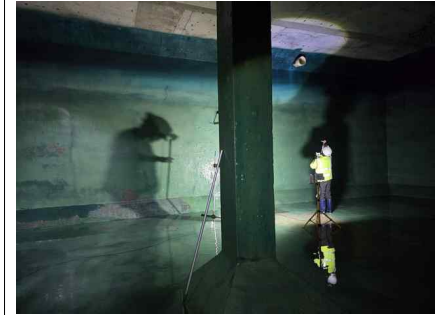
<내부 개별부재 외관조사>
